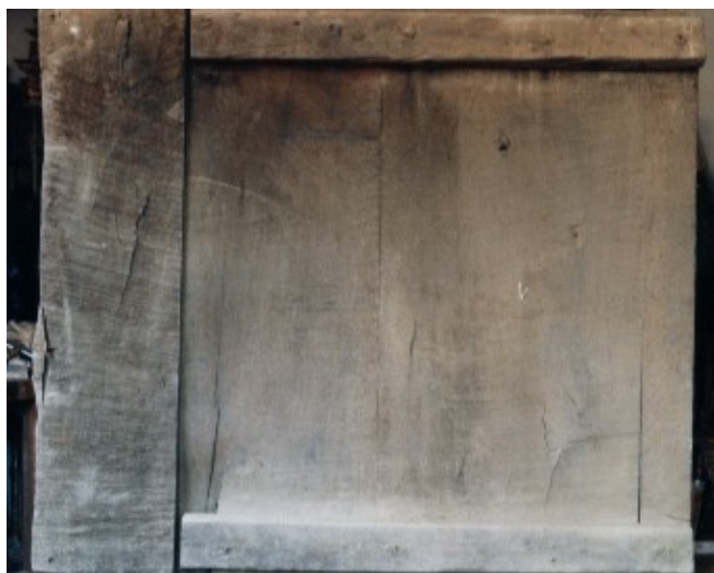
Figuras 73 y 74. Injertos de madera de pino en la estructura
