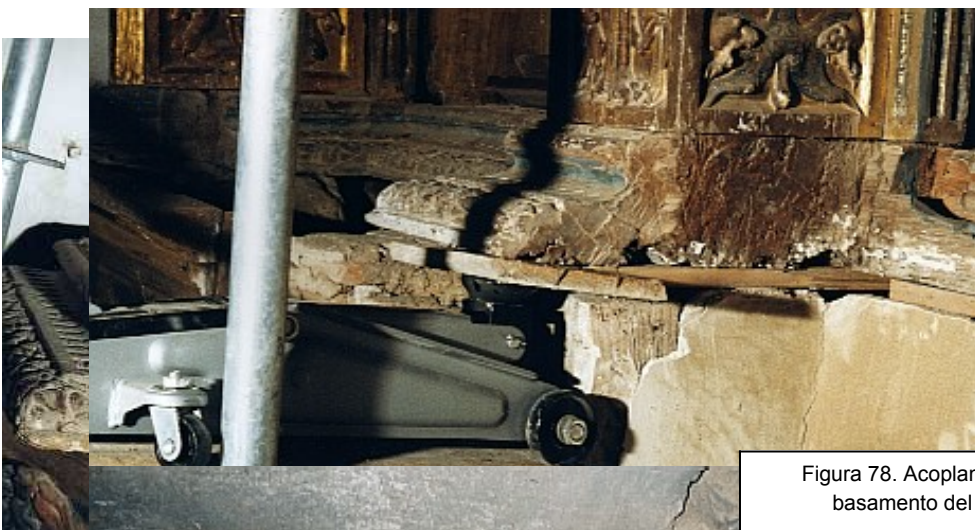
Figura 79. Elevación mediante un gato hidráulico de los cimientos y reforzamiento de la base
