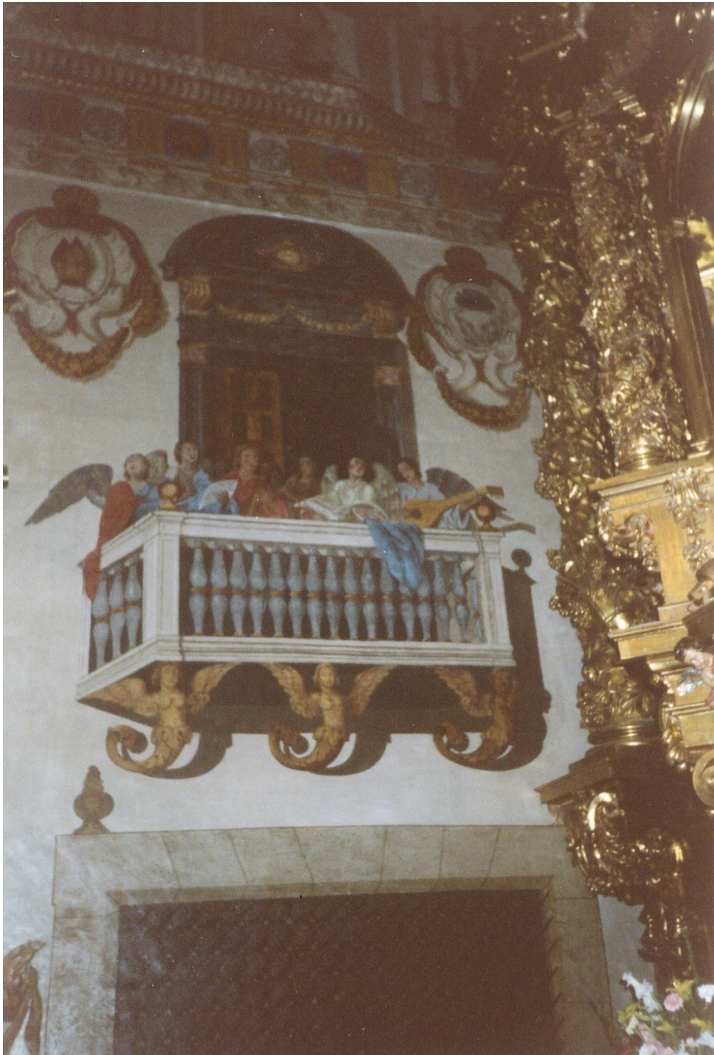
Figura 135. Estado de conservación de las pinturas laterales
