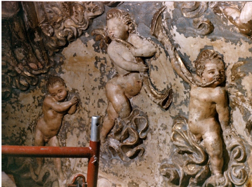
Figuras 153 y 154. Pésimo estado de conservación
