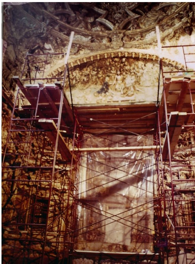
Figura 158. Andamio montado durante la intervención
