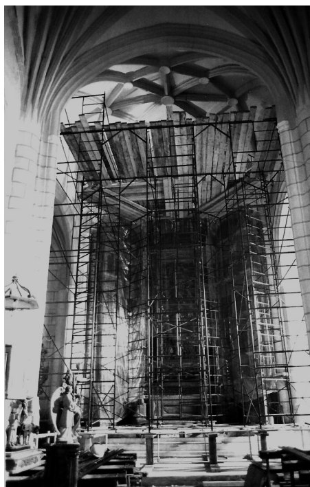
Figura 18. Retablo Mayor de San Pelayo con andamio
