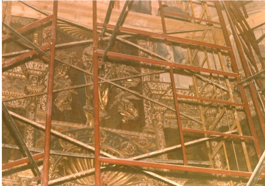
Figura 25. Andamio montado durante la intervención
